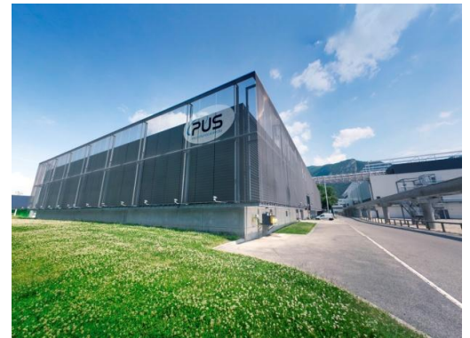
Cofely Services – Pôle Utilités Services / MINATEC
